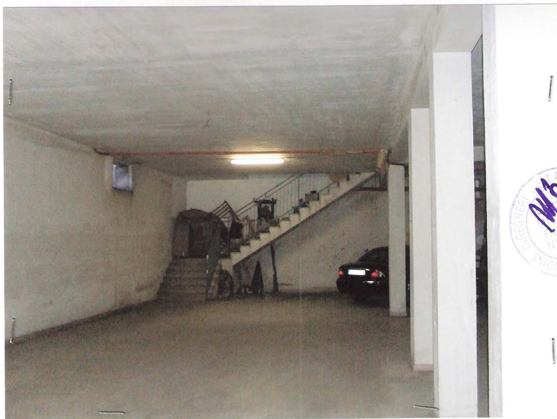
Foto n° 6 - LOTTO n. 2 : Particolare rifiniture interne dell'Autorimessa – Apricena (FG).
