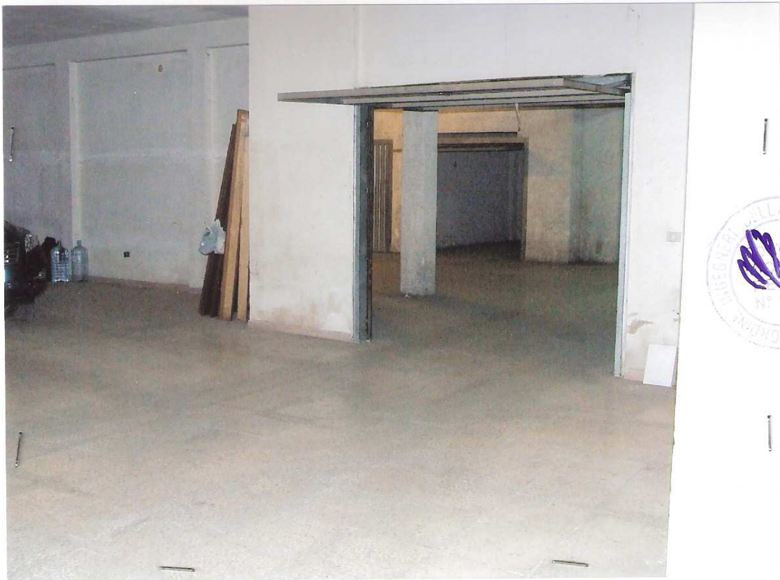
Foto n° 10 - LOTTO n. 2 : Particolare rifiniture interne dell'Autorimessa – Apricena (FG).
