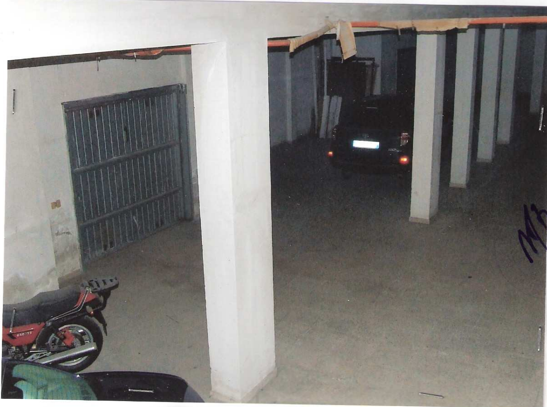
Foto n° 4 - LOTTO n. 2 : Particolare rifiniture interne dell'Autorimessa – Apricena (FG).
