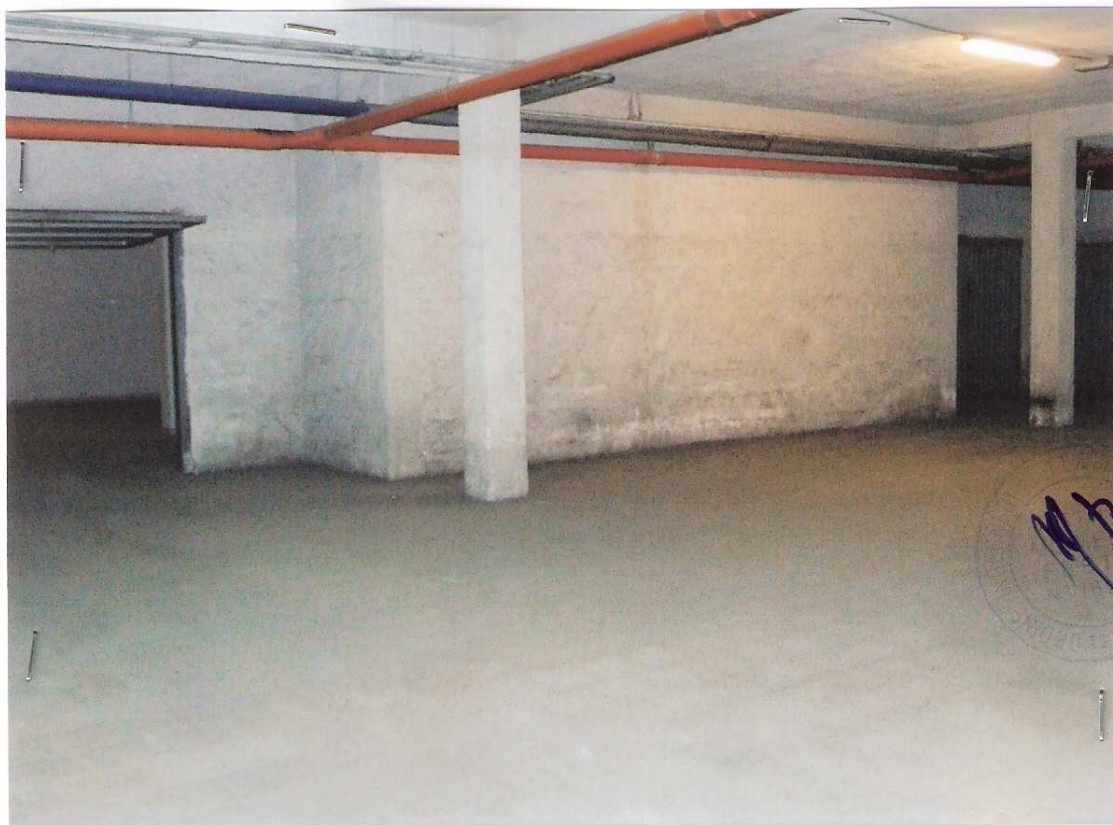
Foto n° 5 - LOTTO n. 2 : Particolare rifiniture interne dell'Autorimessa – Apricena (FG).
