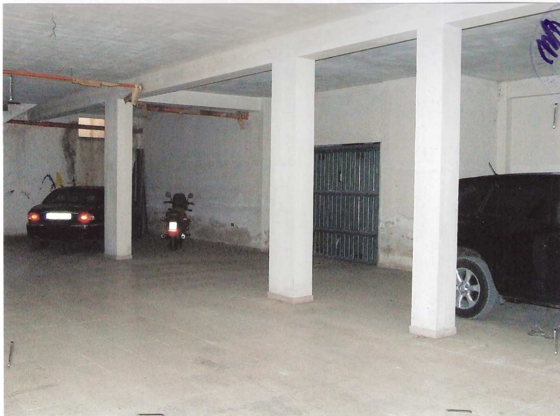
Foto n° 8 - LOTTO n. 2 : Particolare rifiniture interne dell'Autorimessa – Apricena (FG).
