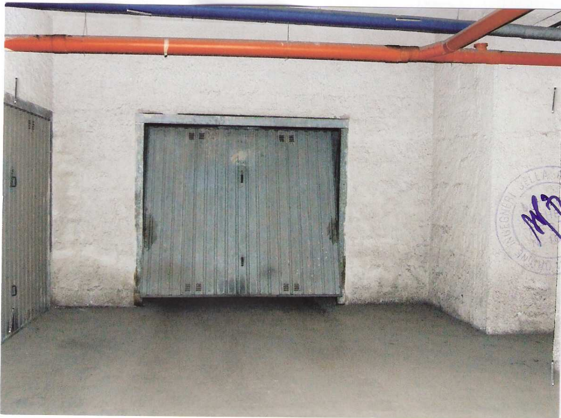
Foto n° 3 - LOTTO n. 2 : Particolare ingresso all'Autorimessa dalla corsia di manovra condominiale dello stabile di appartenenza dell'immobile pignorato – Apricena (FG).
