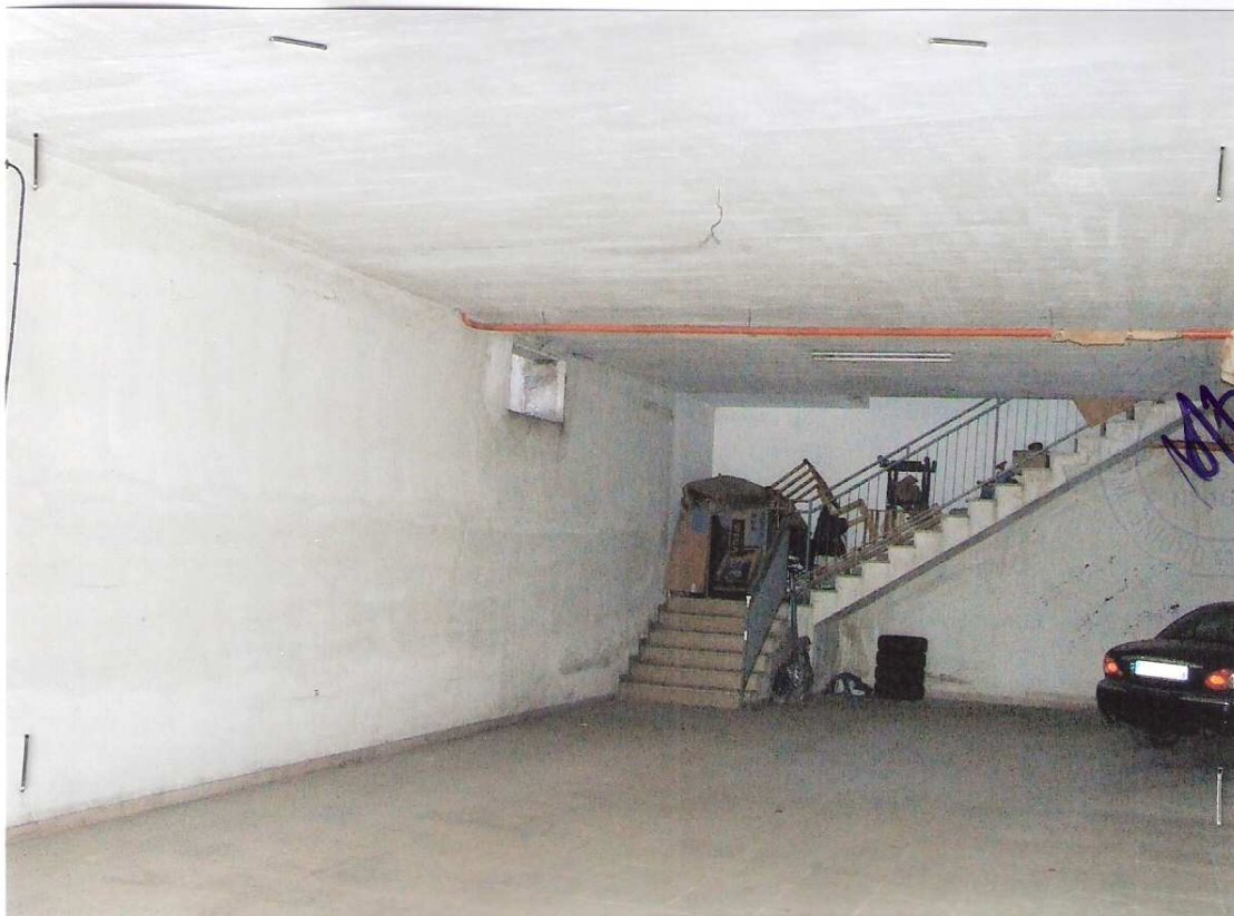
Foto n° 7 - LOTTO n. 2 : Particolare rifiniture interne dell'Autorimessa – Apricena (FG).
